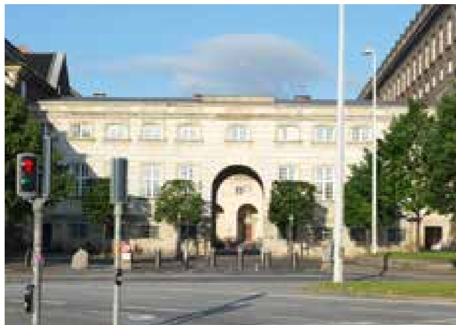
Eksisterende pullertanlæg ved indgangen til Rigsdagsgården
