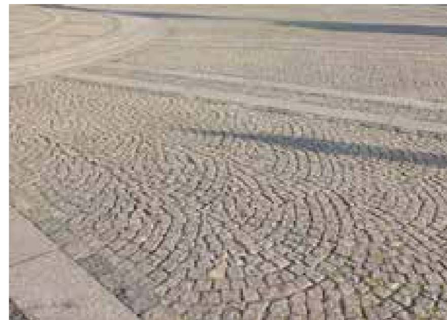
Det primære belægningsmateriale på den nuværende slotsplads er chaussésten lagt i felter. I forslaget til den nye slotsplads genbruges chausséstenene
