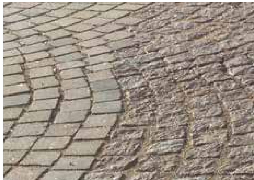
Gangvenlig belægning af savede chaussésten danner et spor i belægningen med kløvede sten
