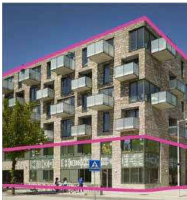
Fig. 6.2r: Etageboliger og erhverv i mere end 3 etager skal fremstå med en karakteristisk horisontal todeling, sådan at de nederste etager fremstår med hver sin arkitektoniske bearbejdning, hvorved bygningen nedskaleres.
