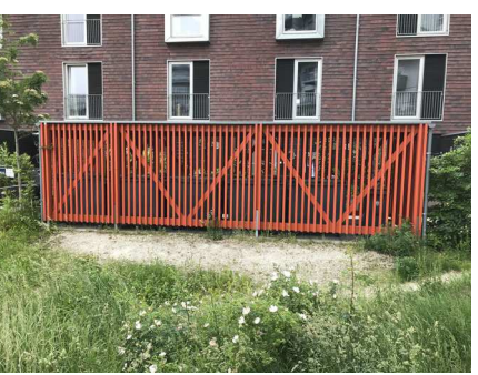
De 2 eksisterende skure flyttes og tilpasses til projektet. Farve og materialer fastholdes.
