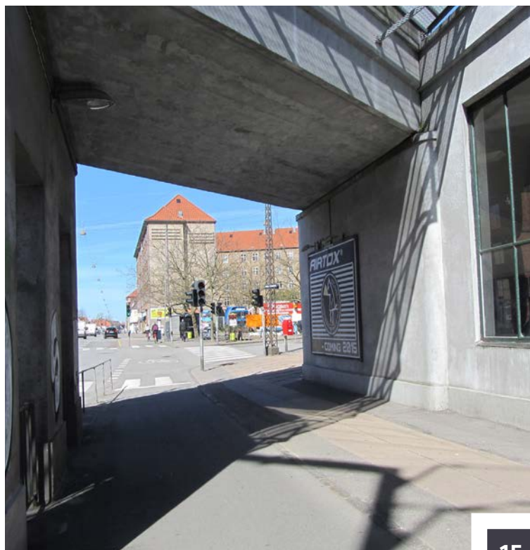
Kig til Herman Bangs Plads fra viadukten under Langgade Station
