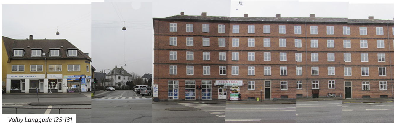
Langgade Station og banevolden
