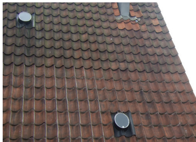
Tagfladen med de originale, ovale tagvinduer
