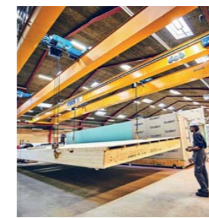
1. Moduler til havehusene samles til bokse på en fabrik
