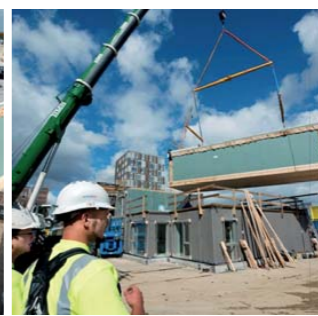
4. Boksene løftes på plads og monteres på stedet.
