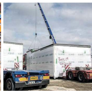
2. Svanemærkede, færdige bokse pakkes og hejses på lastbiler, klar til transport.
