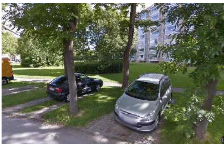
Referencebillede fra Kobbervænget, København med parkering på græsarmering under trækroneerne.
