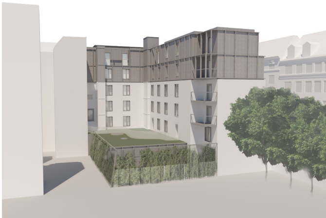
Visualisering, der viser et eksempel på udformning af de 2 nye etager og det hævede gårdrum set fra Borngøhus. Illustration: Albjerg & Buchardt.
