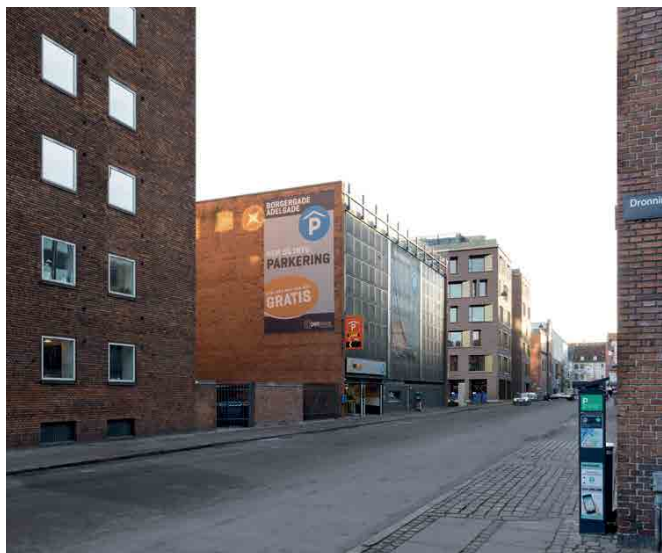
Foto af de eksisterende forhold set fra Adelgade mod syd. Foto: Kim Utzon Arkitekter.
