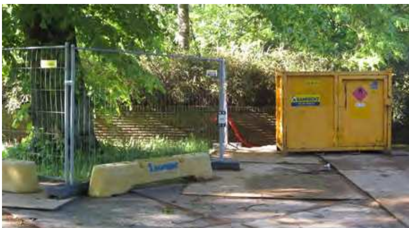
Figur 7.7.4. Træ på byggeplads. Træernes drypzone er ofte sammenlignelig med udbredelsen af træernes rodnet.
