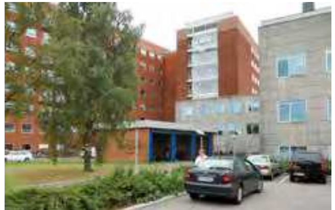
Det eksisterende Lersøkompleks set fra nord.
