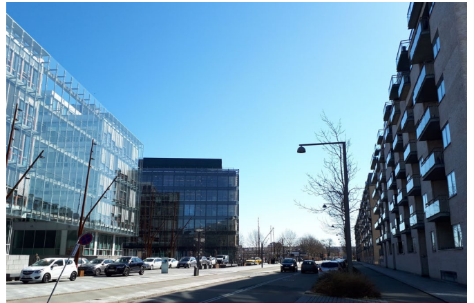
Lokalplanområdet set fra Weidekampsgade
