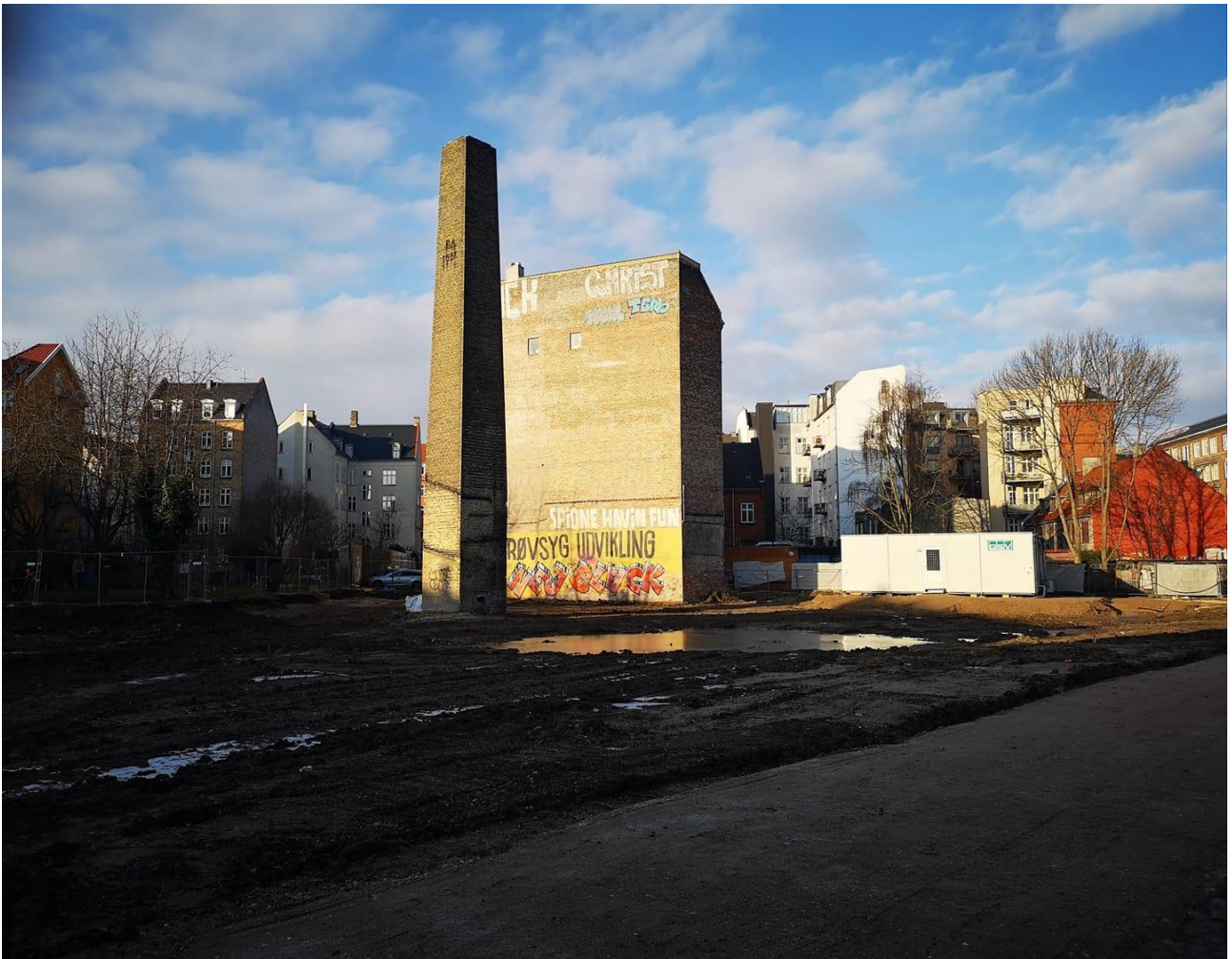
Skorsten efter afkortning, før renovering af fuger. Illustration: Ejendomsselskabet Enghaven A/S
