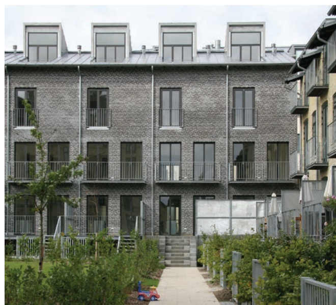
Privat kantzone ud mod en fælles baggård. Porcelænshaven, Frederiksberg. Foto Juul & Frost Arkitekter.
