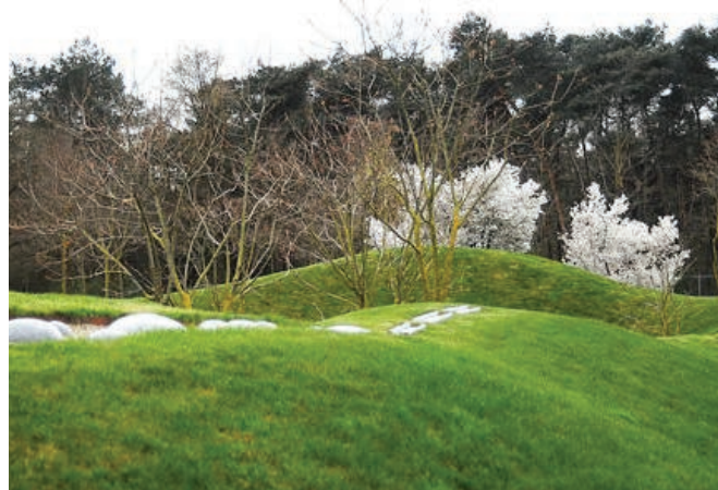
Bella Centers have er beliggende oven på et parkeringsanlæg. Ved at tilføje jordbakker kan der opnås bedre vækstforhold for beplantningen.
