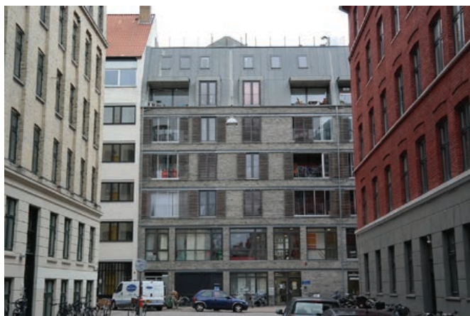
Eksempel på skift i facader så byggefelt fremstår som bebygget med flere bygninger.
