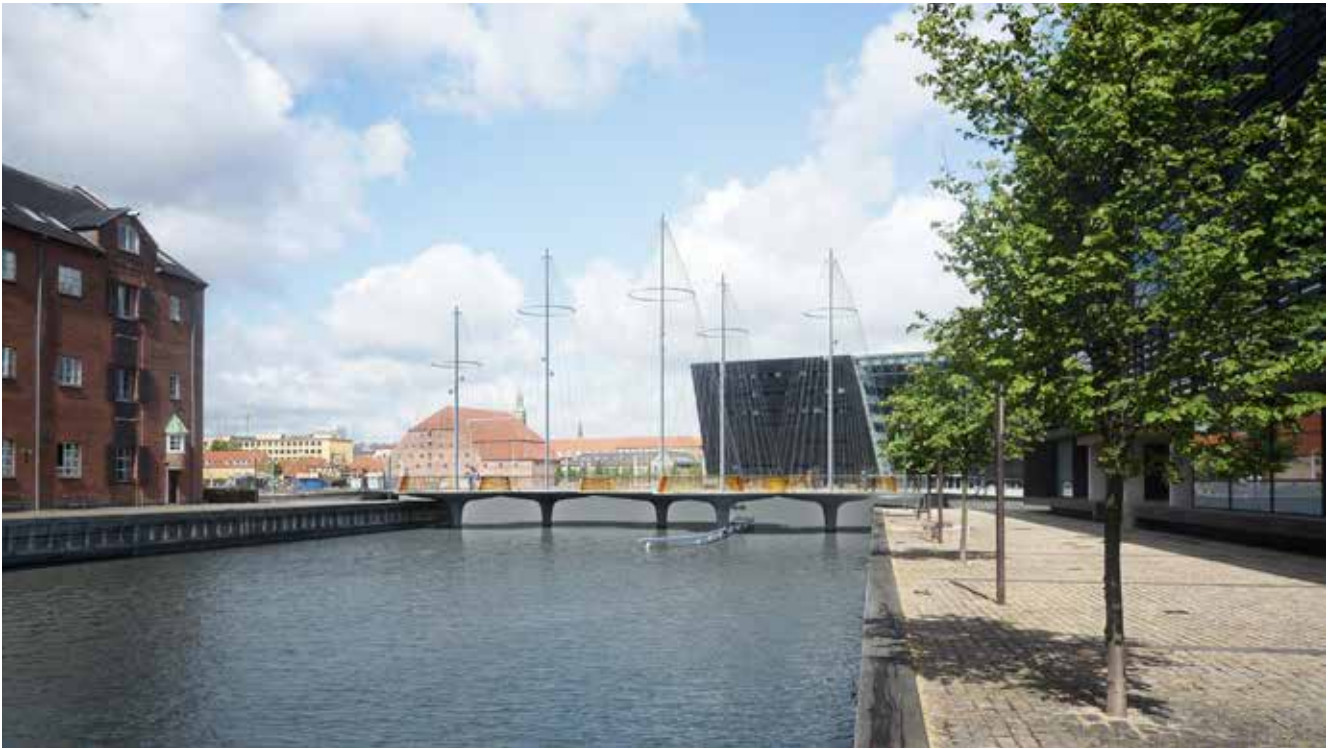
Den lukkede bro set fra Christianshavns Kanal
