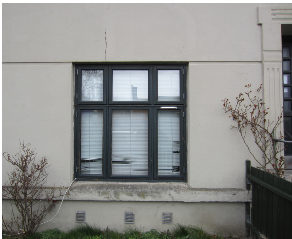
Udskiftning af vinduer til nye koblede trærammer med tre lag glas
