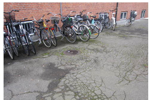
Regnvandsopsamling og retablering med permeabel belægning
