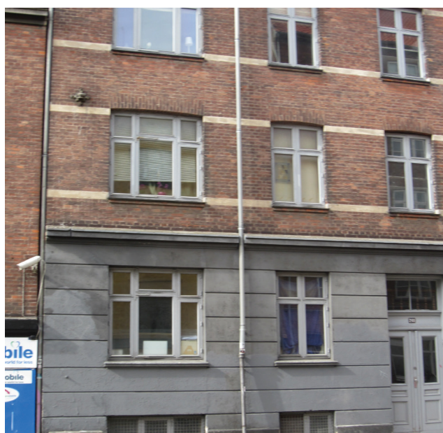
Facaden istandsættes og fugerepareres
