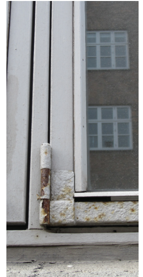
Vinduer udskiftes og energi- og støjoptimeres
