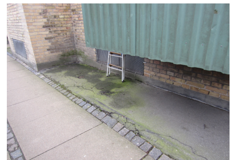
Efterisolering af etageadskillelse mod kælder
