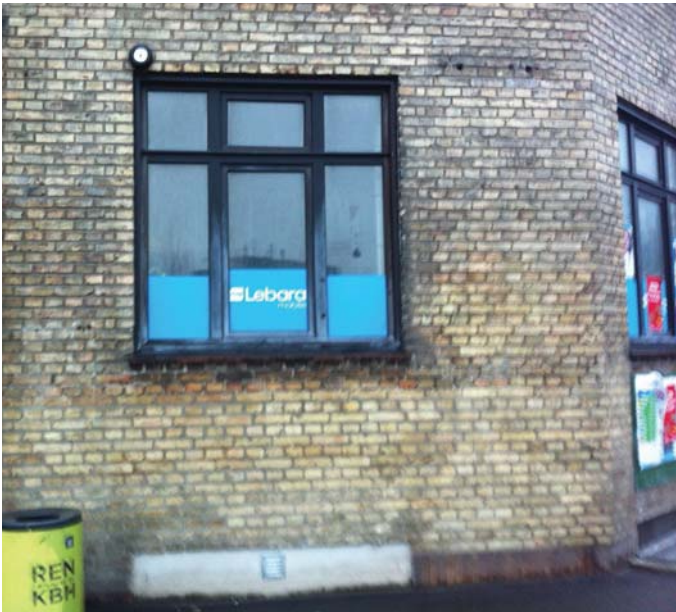
Vinduer mod gade udskiftes og til lydisolierende vinduer
