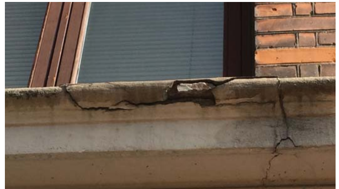
Vinduer istandsættes og energioptimeres og facader tættes
