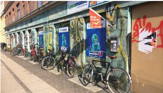
Underfacade istandsættes og lyskasser nedlægges pga. fugt
