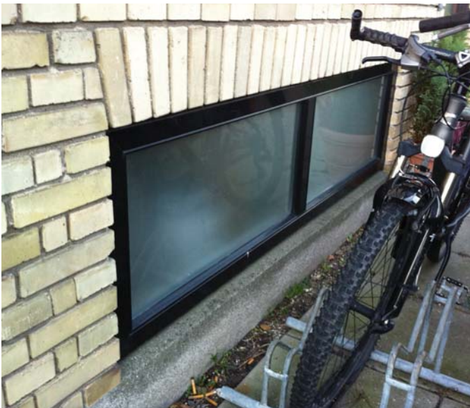
Punktvis tætning af betonfundament og skybrudssikring
