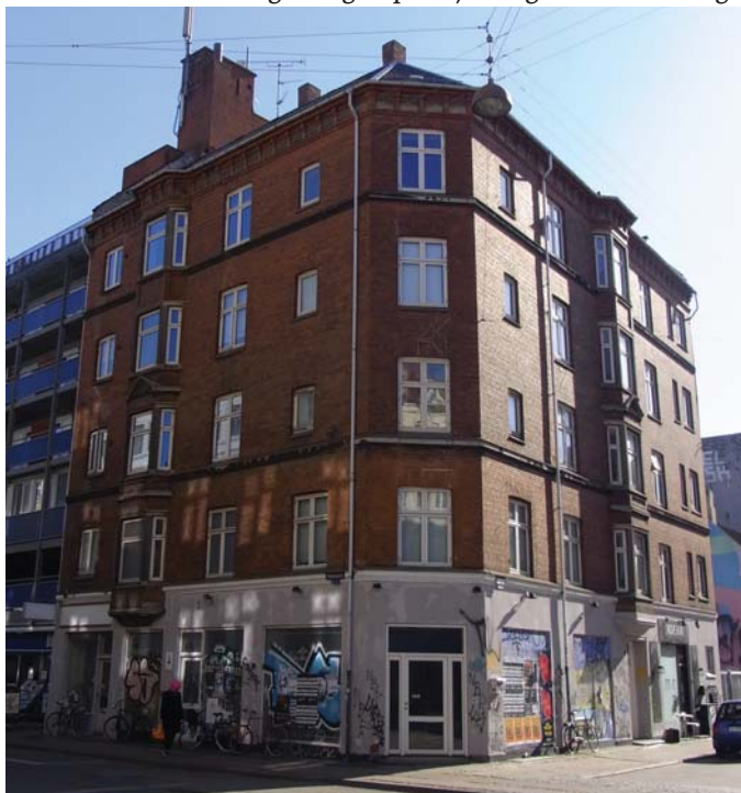
Vinduer og karnapper er væsentligt nedslidte
