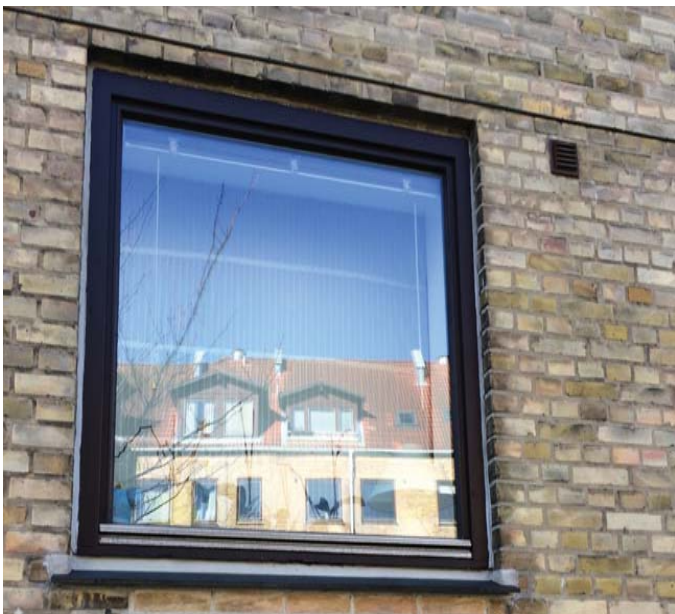
Vinduer udskiftes til lyd-dæmpende lavenergivinduer.
