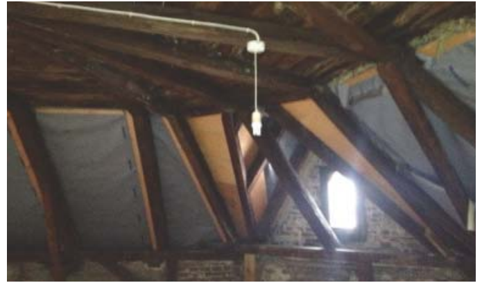
Tag efterisoleres i etageadskillelsen
