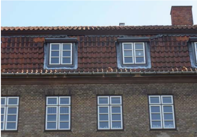
Tag udskiftes og efterisoleres
