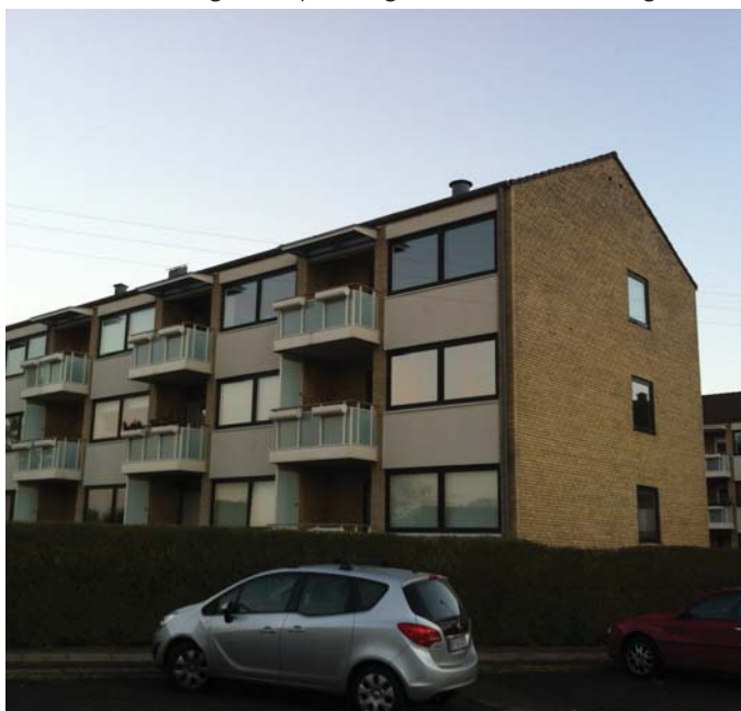
Facade mod Hedegaardsvej. 8 frie gavle isoleres udvendigt
