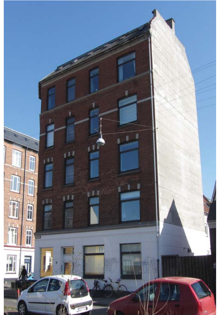
Facade mod Provstevej. To endegavle isoleres udvendigt
