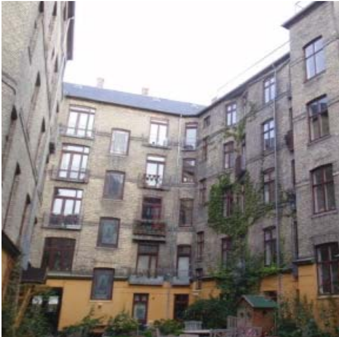
Facade mod gård istandsættes og tætnes
