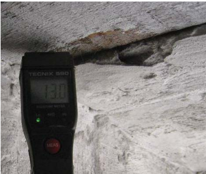
Etageadskillelse mod kælder isoleres
