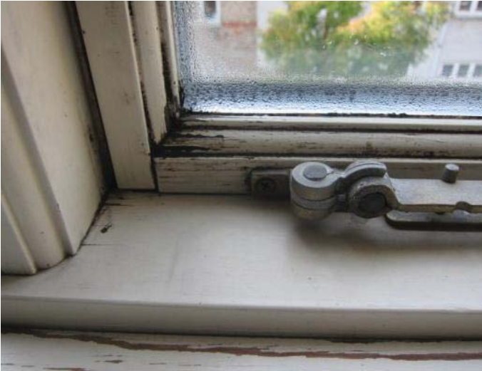
Vinduer mod gård tjenlige til udskiftning
