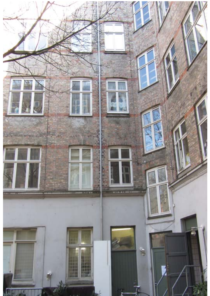
Facade mod gård eftergås og vinduer udskiftes
