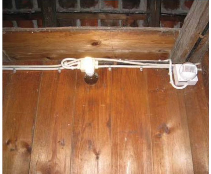
Udskiftning til energibesparende lysarmaturer i kælder
