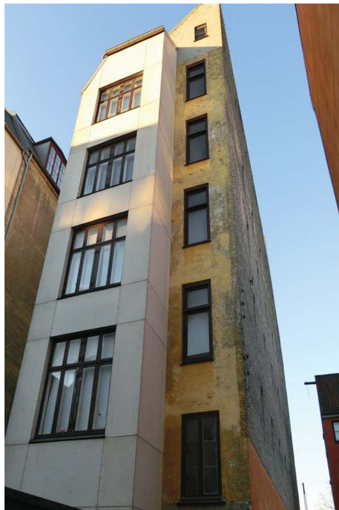
Efterisolering af gavle
