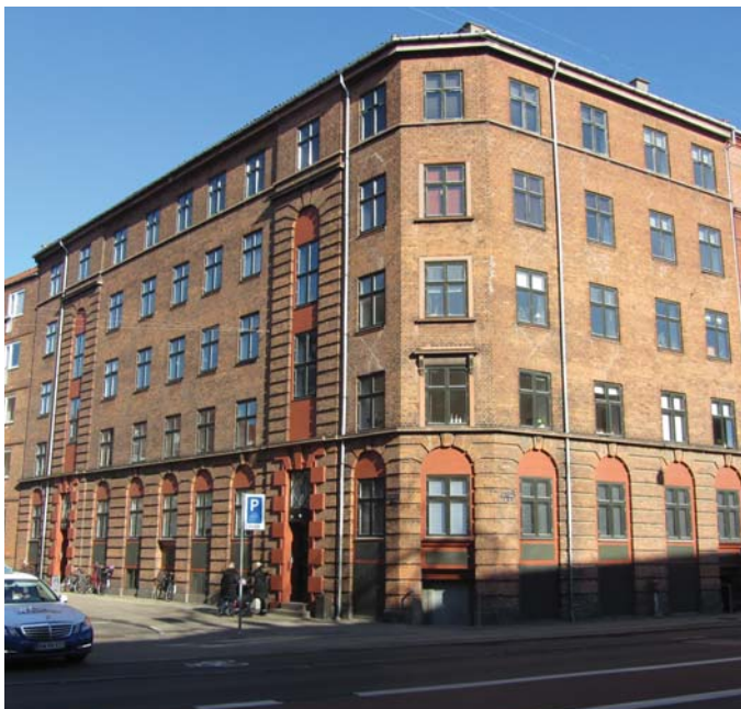
Facade mod Kurlandsgade og Sundholmsvej
