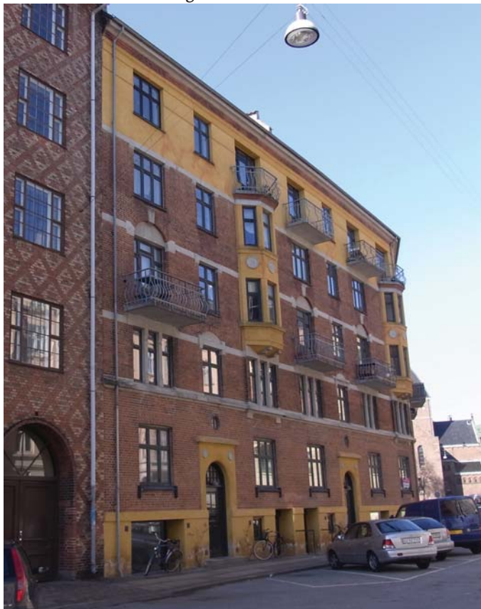
Facade mod Henrik Rungs Gade. Vinduer istandsættes
