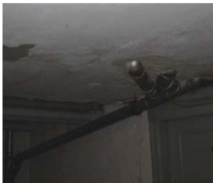
Etageadskillelse mod kælder isoleres
