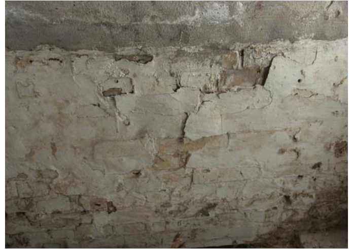
Fugt i kældervægge indvendigt udbedres
