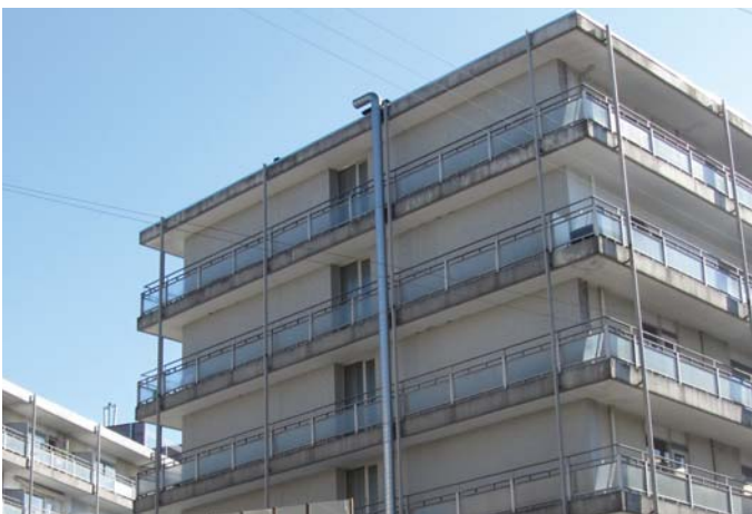
Etablering af nye vinduer og nye franske altandøre i ny facade
