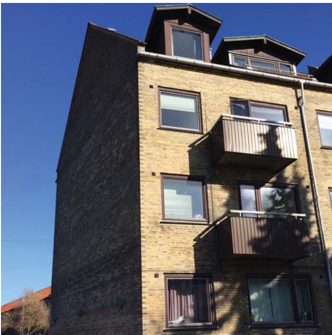
Murværk tættes og gavle isoleres
