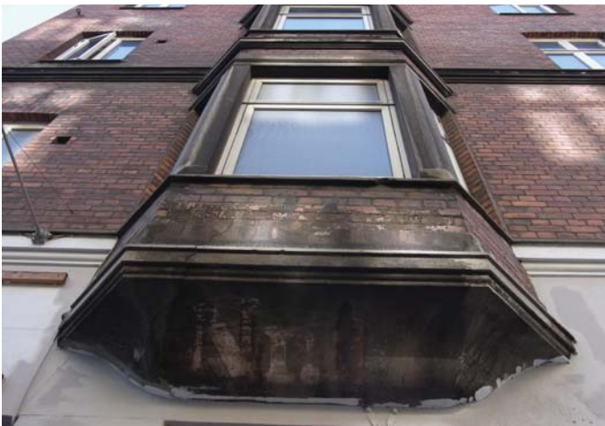
Vinduer og karnapper er væsentligt nedslidte
