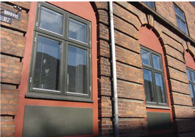
Vinduer udskiftes og lydisoleres
