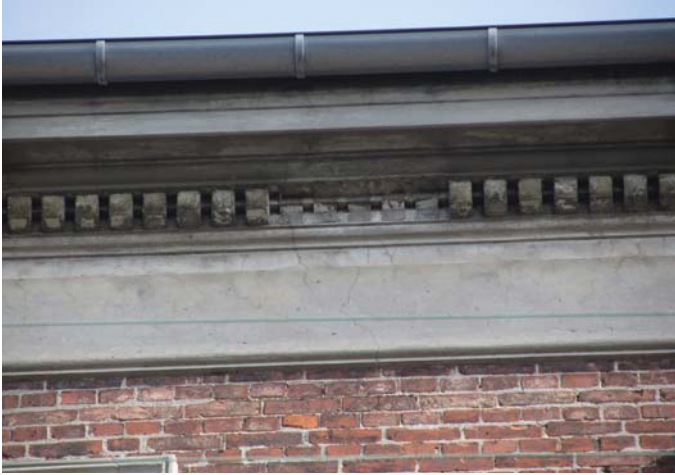
Murkrone mod gade og gård reparereres
