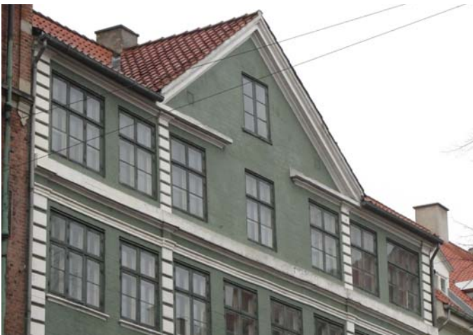
Tag istandsættes og efterisoleres
