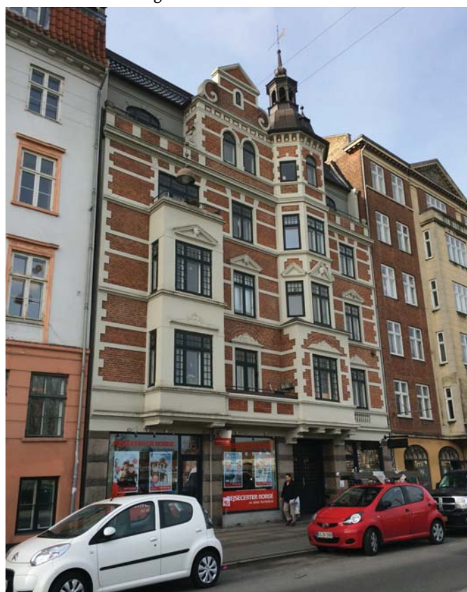
Facade mod Gothersgade. Istandsættelse af vinduer i erhverv
