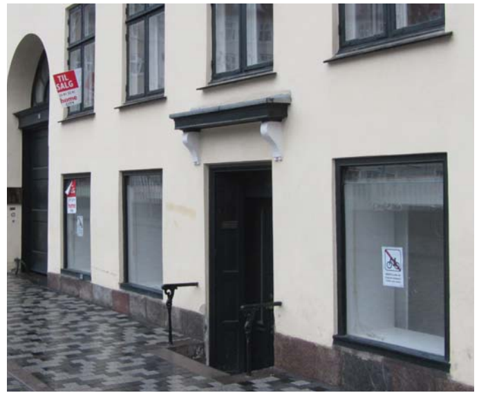
Eksisterende yderdøre istandsættes og tætnes
