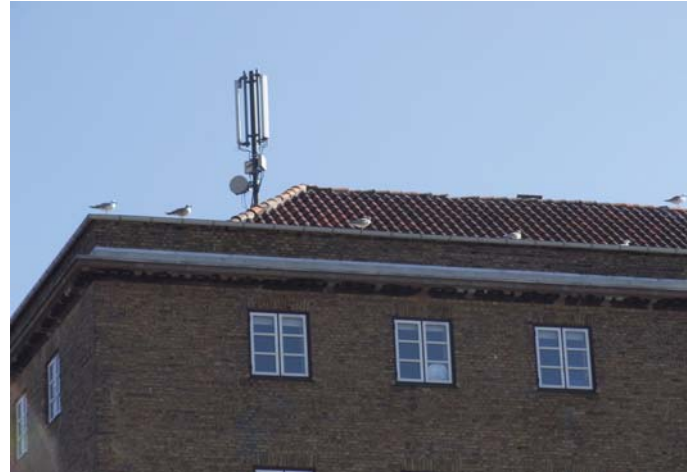
Der opsættes solceller på taget på gårdsiden
