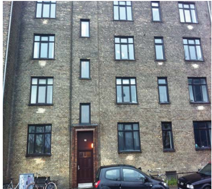
Facade tætnes ved omfugning
