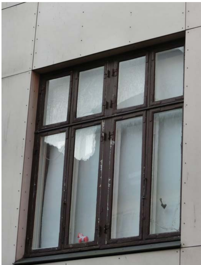
Vinduer energioptimeres og istandsættes
