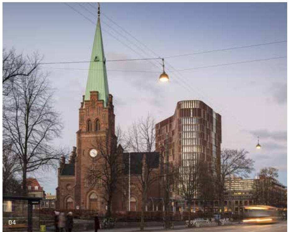
03 Ny Vestergade 3 Tegnestuen B19 / Færdig 2013 Ny Vestergade 3 er et byhus fra 1848, der er renoveret og ombygget. Det oprindelige hus er bevaret, og der er tilføjet en ny tagetage. Det nye mødes direkte med det gamle som en nutidig fortolkning af de eksisterende arkitektoniske træk.
