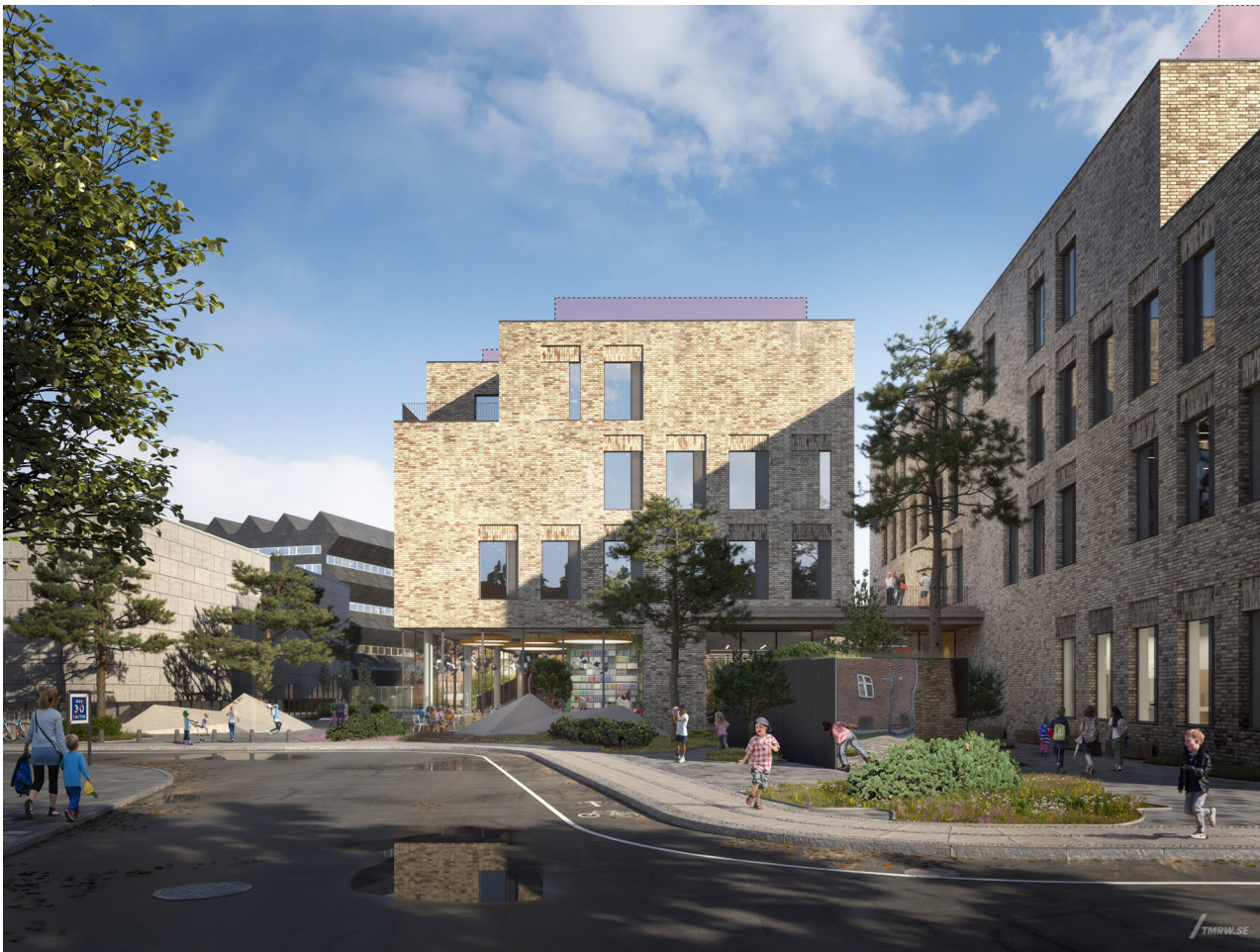
Illustration på side 6 i lokalplanen udskiftes med denne, med teknik på tag
