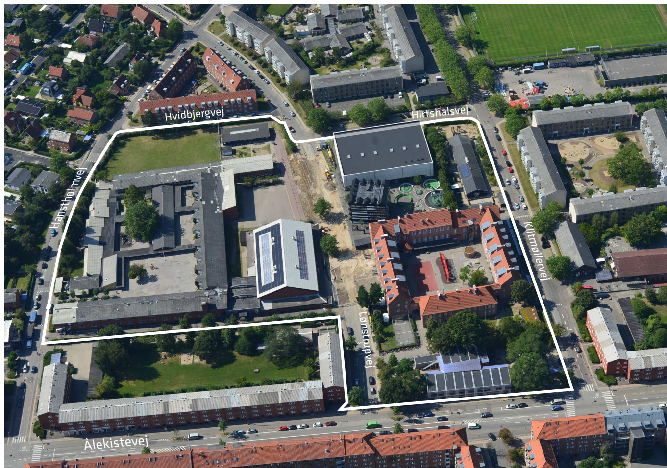
Luftfoto af lokalplanområdet set fra øst. Lokalplanområdets afgrænsning er vist med hvid linje.
