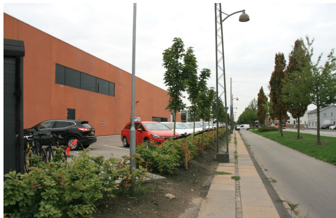
Gammel Køge Landevej set mod syd efter krydset ved Blushøjvej. Bygningen rummer engrosvirksomheder og fremtræder lukket. Der er en smal, grøn kantzone langs vejen og parkering foran bygningen.
