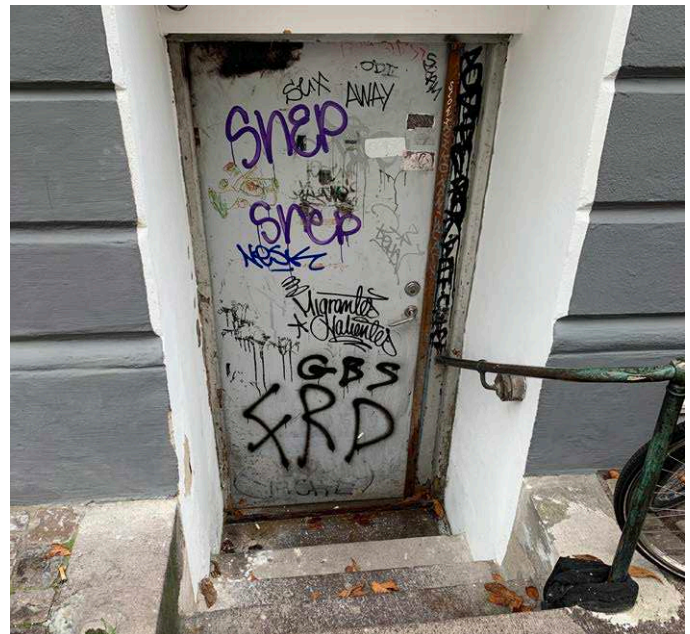
Udvendige døre udskiftes
