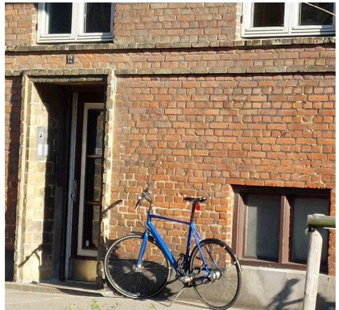
Istandsættelse af facader og udvendige døre
