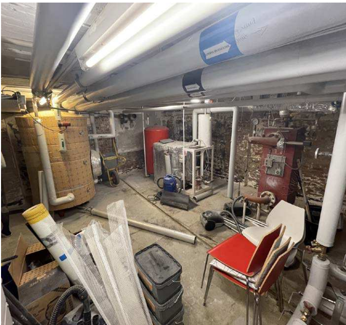
Ejendommen tilsluttes fjernvarme
