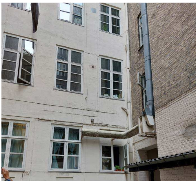
Renovering og oprydning af facader
