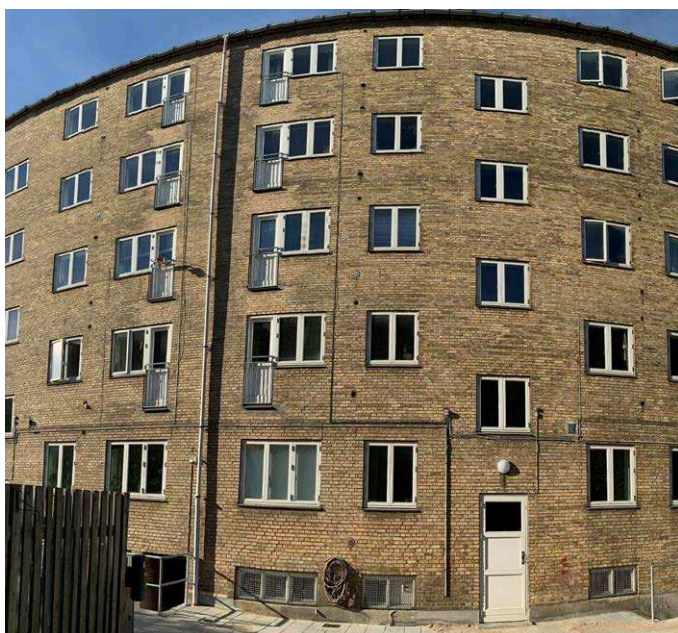
Skybrudssikring af kældernedgange
