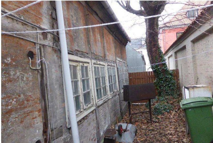
Bindingsværk ved nord facade
