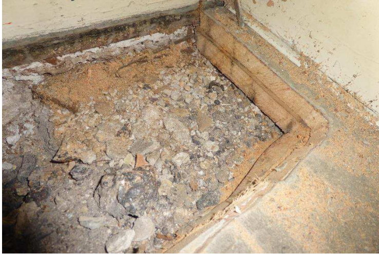
Gulvbrædder direkte på jordlag
