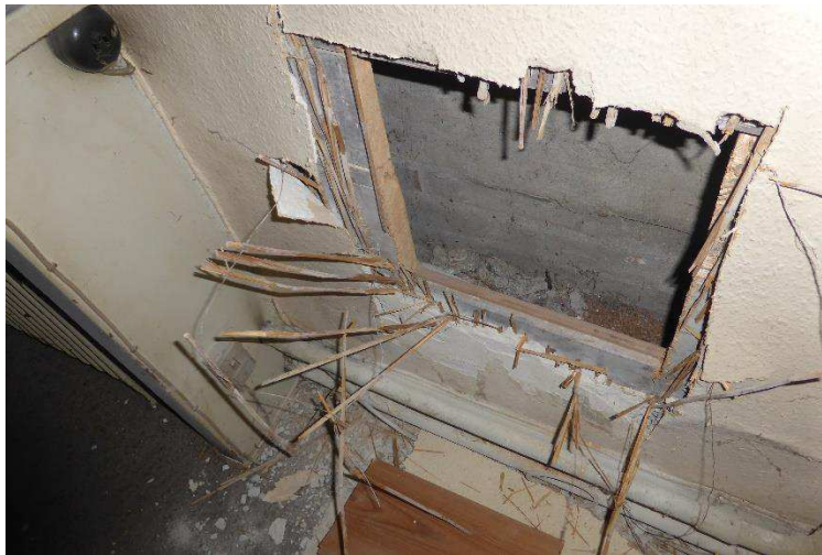
Forsatsvæg af pudset bræddebeklædning
