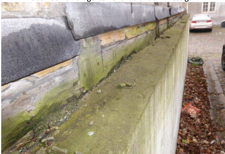
Støbt betonvæg på den nedre del af bindingsværkskonstruktionen
