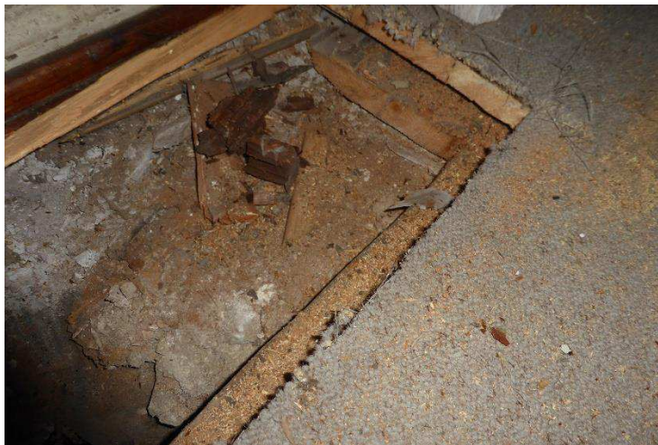
Gulvbrædder direkte på jordlag
