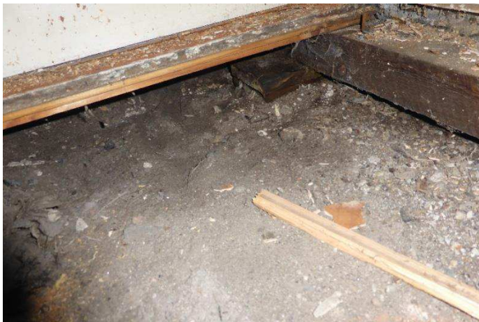
Opklodset bjælke i terrændæk i UO1
