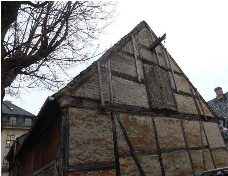
Udsnit af bindingsværkskonstruktion i vest gavl
