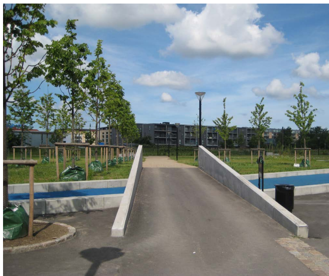
Rampe i Mimersparken i retning mod underføringen
