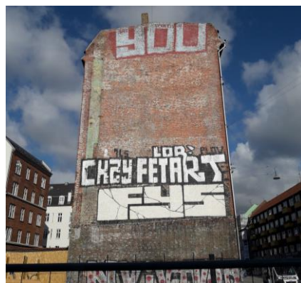
Billede fra stedet - Ikonisk gavl mod Svanevej 2. Byggearbejdet for 41 ungdomsboliger er netop begyndt.
