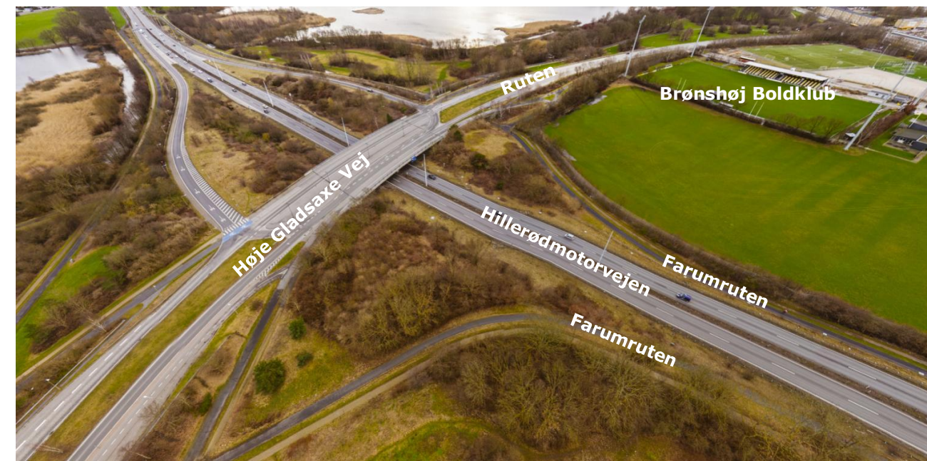
Figur 5. Dronefoto med eksisterende vej- og stiforbindelser set mod sydvest
