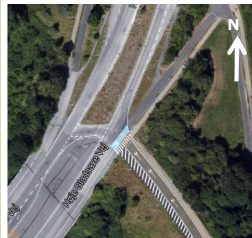
Krydset med tilkørselsrampen øverst og krydset med frakørselsrampen nederst (Google Maps)
