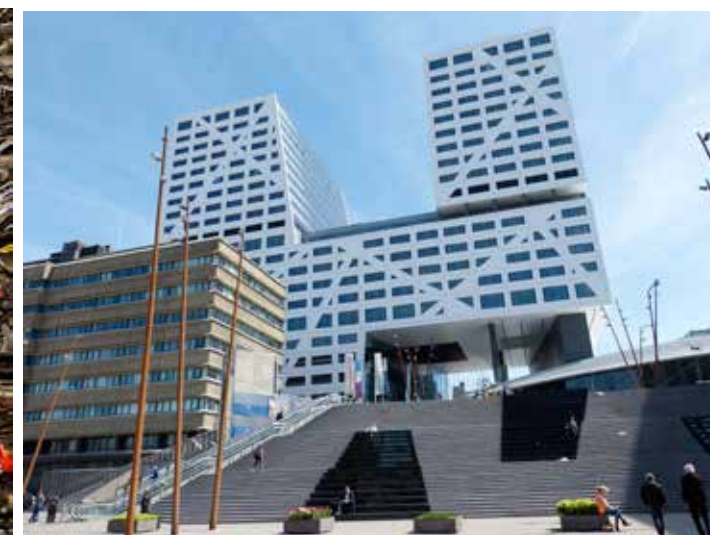
Ny stationsforplads med banegårdsbygning og nyt rådhus i baggrunden over sporene. Adgangen til cykelparkeringsanlægget med plads til 4200 cykler kan skimtes til venstre integreret i trappen Foto: Anita Dirix
