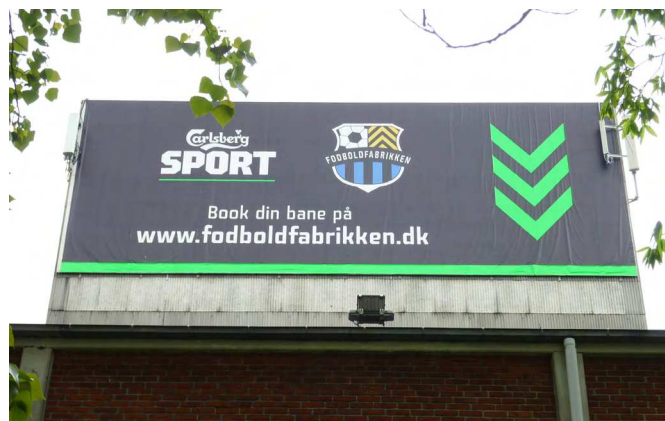
Bygningen set fra Kløvermarken
