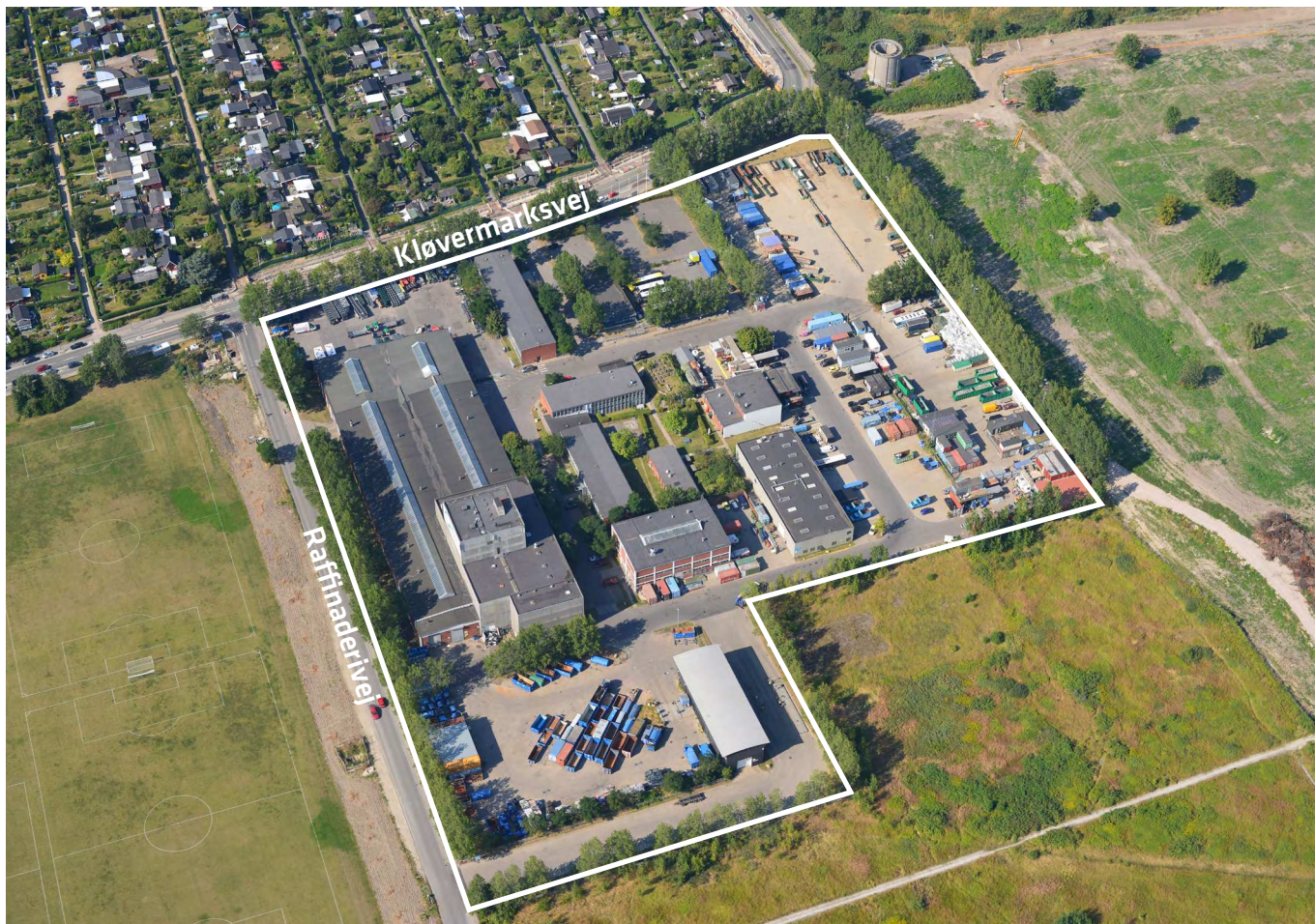
Luftfoto af lokalplanområdet set fra syd
