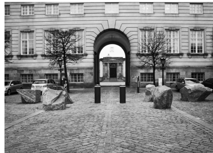
Eksisterende pullertanlæg ved indgangen til Prins Jørgens Gård
