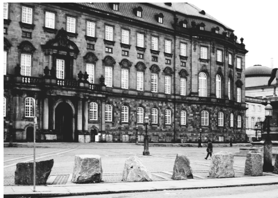
Midlertidig sikring med granitblokke
