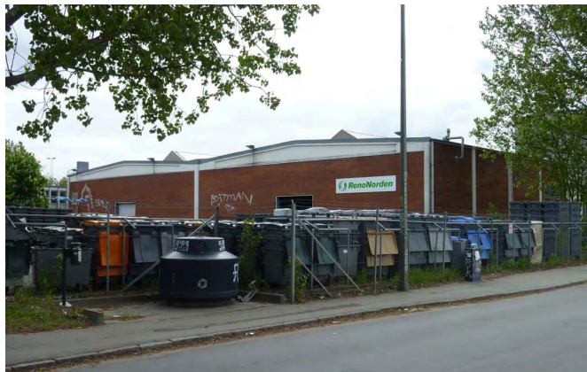
Bygningen set fra Raffinaderivej
