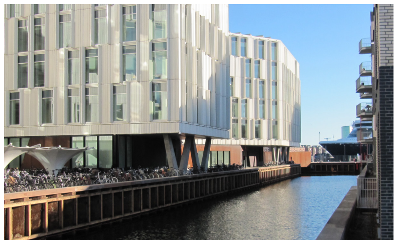
Kanalen mellem den østlige bolighalvø og FN-byen
