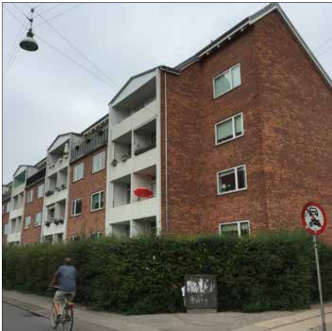
Ejendommen set fra Spontinisevej/Wagnersevej.
