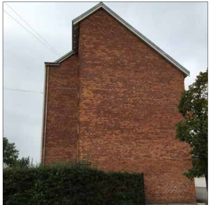
Den ene af to markante gavle, der isoleres.
