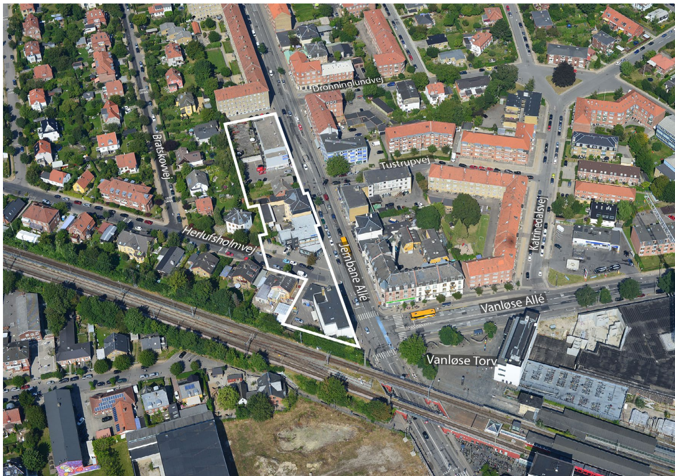
Luftfoto af lokalplanområdet set fra syd
