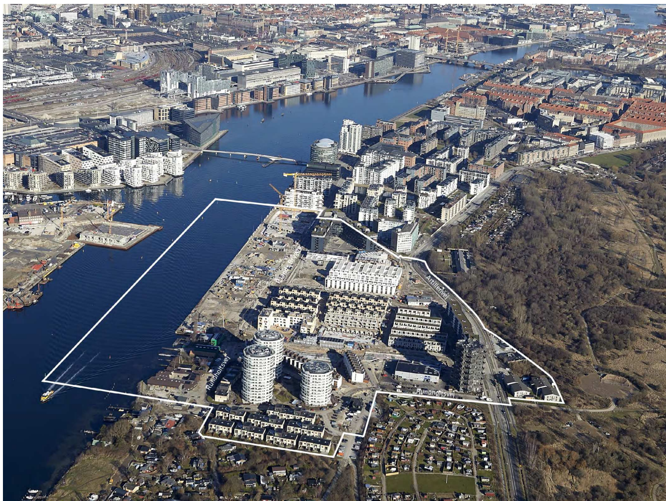
Lokalplanområdet set mod nord med havnen og Enghave Brygge til venstre og Amager Fælled til højre. Nord for området ligger Havne- og Islands Brygge. Foto: JW Foto - Februar 2016.
