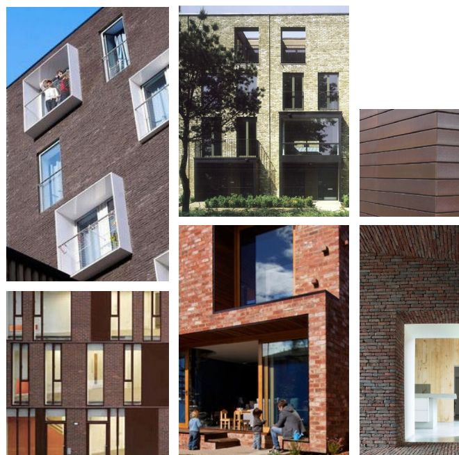
Referencer på facademateriale i form af rødbrune tegl, skærmtegl, lakeret stål m.v. samt variation i udformningen af vinduer, karnapper og 'murhuller'. Fotos: Entasis.
