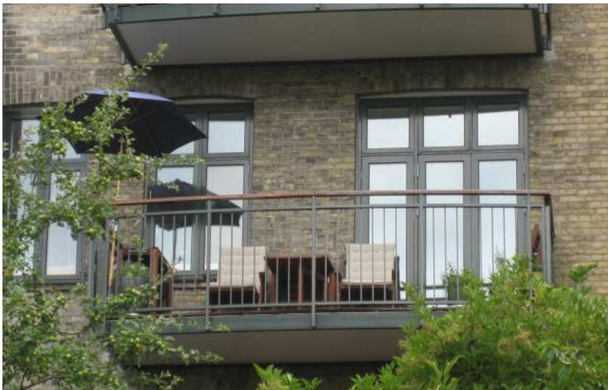
Dørpartiernes tværpost flugter smukt med vinduernes tværpost. Altankant og værn har fået samme farve som vinduer og dør. Hostrupsvej 8.
