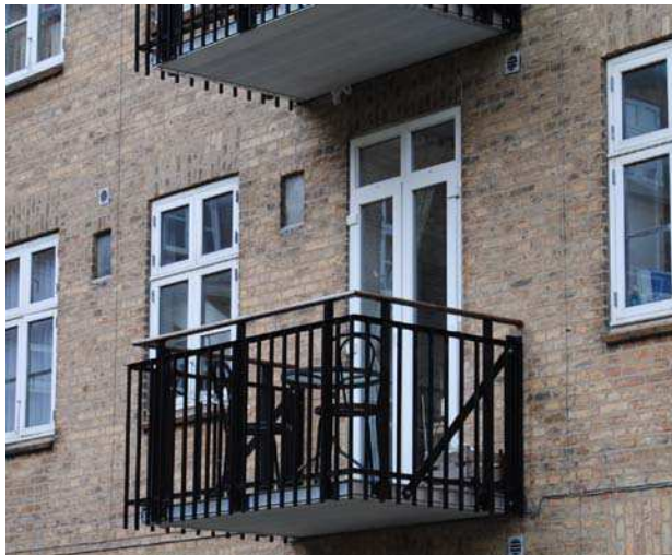
Billede nr. 2: Skråbæringer som ikke strækker sig ud over altanens højde.
