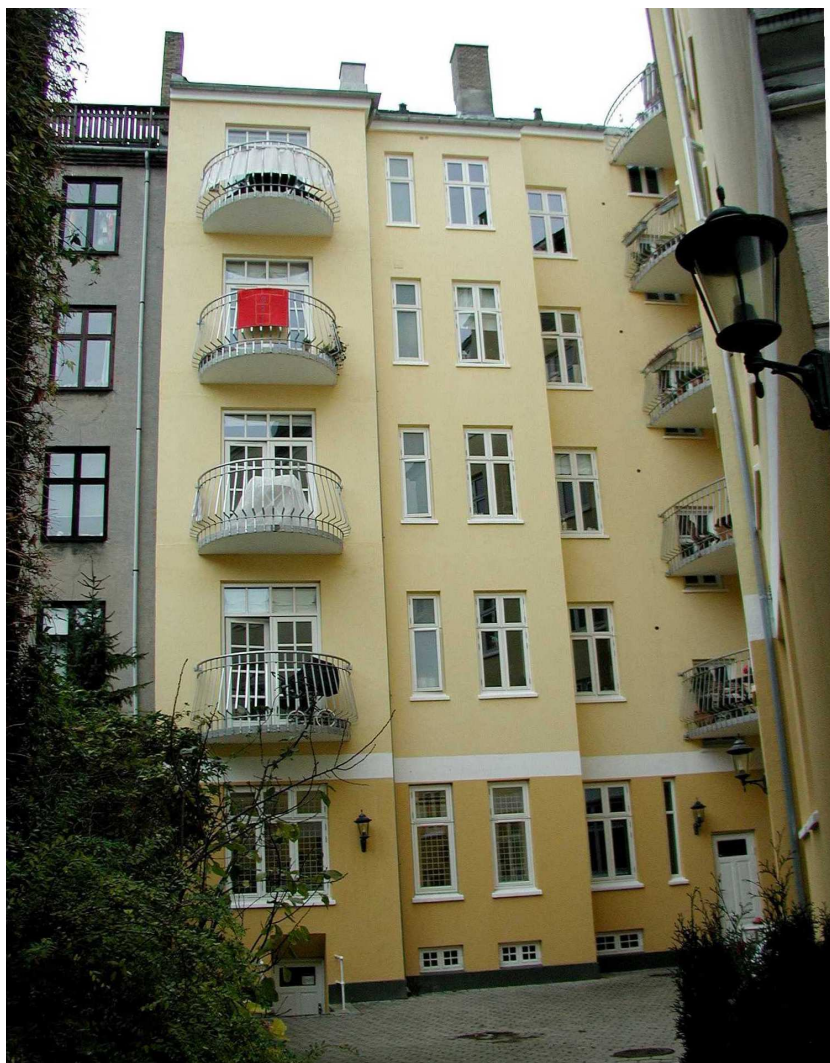
Bülowsvej 48B med nye altaner smukt centreret på både fremtrukket facadeparti og om to-fløjet dørparti.
