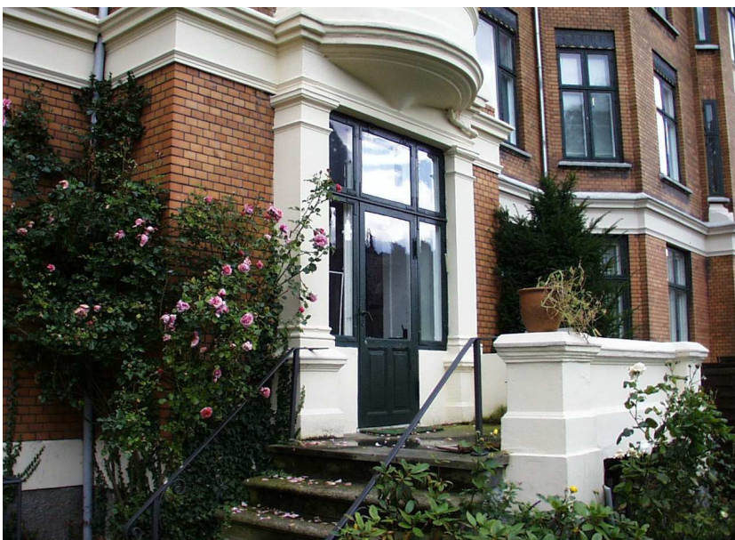
Kochsvej 5 med smukt udformet hævet plataeu ud for havedør.
