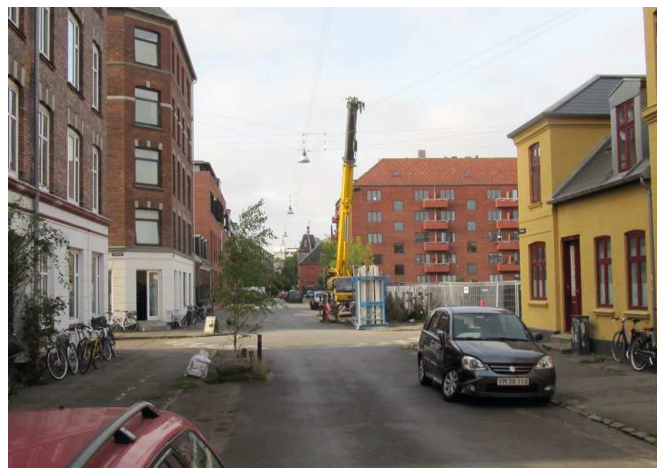
Provstevej set mod syd mod Theklavej og Frederikssundsvej
