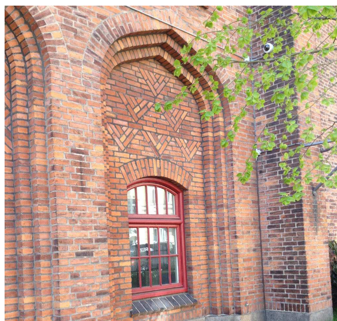
Eksisterende vinduesparti mod Thorsgade
