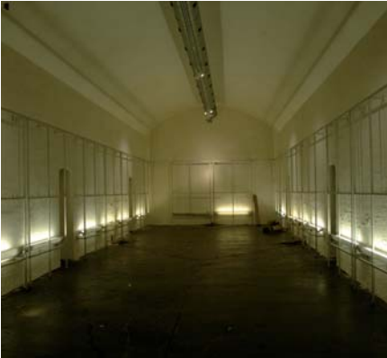
Den eksisterende kælder under pladsen
