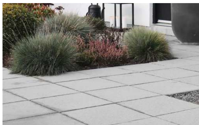
Store betonfliser på det hævede opholdsplateau
