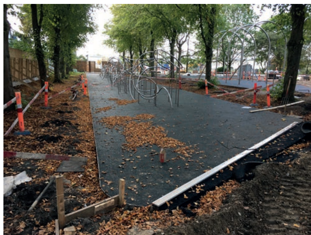
↑ Anlægsarbejde i Remiseparken
