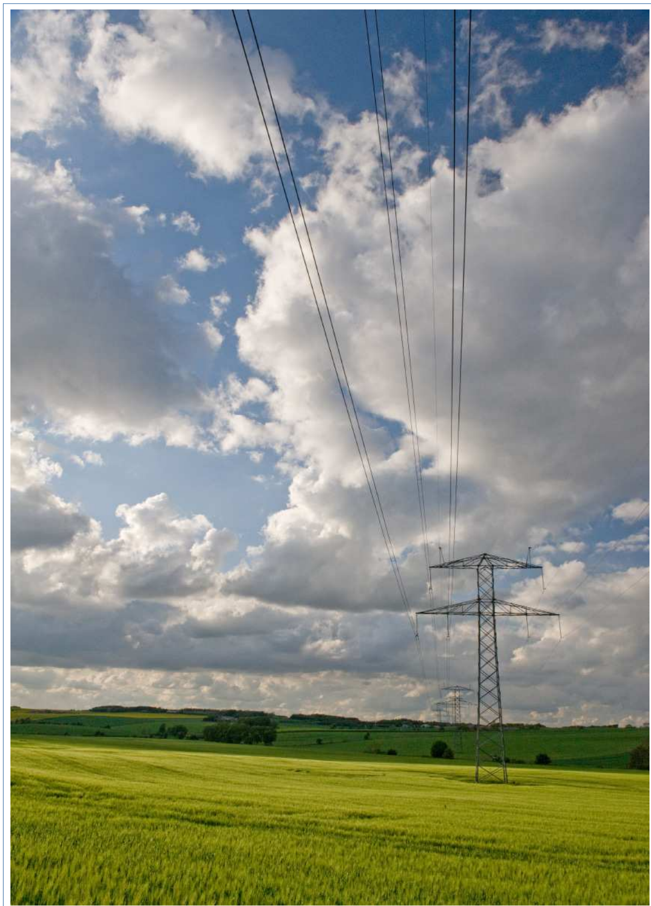
Masterække med et 400 kV ledningssystem og et 150 kV system. Når to systemer samles på én masterække, bliver magnetfelterne ikke automatisk dobbelt så store. De kan i nogen grad udligne hinanden.
