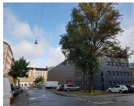
Magasinbygning af Eva og Niels Koppel, der har SAVE-værdi 3. Det foreslås, at den fastlægges som bevaringsværdig i lokalplanen.
