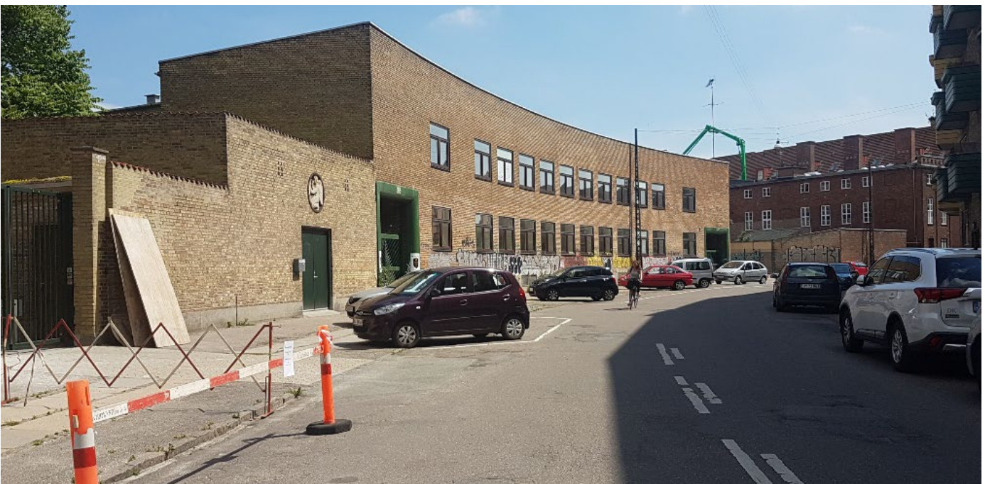
Den bevaringsværdige bygning ligger ud til Hermodsgade og har en buet facade. Facaden har taktfast placering af vinduer og er symmetrisk opbygget med porte i gavlerne med grønne stålkapper og gitterlåger. Bagved ses den karakteristiske bygning med skorstene, der er fredet og tidligere har været kaffebrænderi.
