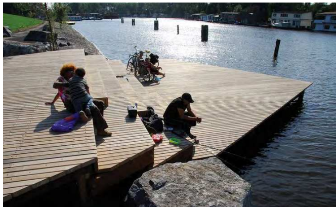
Træbrygge med sidde trin og plateauer til rekreativt brug. Foto af Buro Sant en Co.
