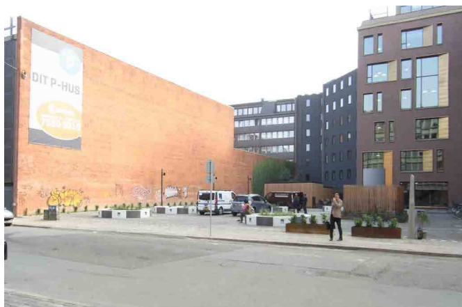
Adelgade med den nye plads ved Turbinehuset
