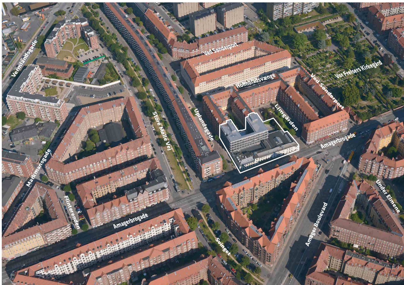
Luftfoto af lokalplanområdet set mod syd. Lokalplanområdet er indrammet med hvid linje. Foto: Københavns Kommune.
