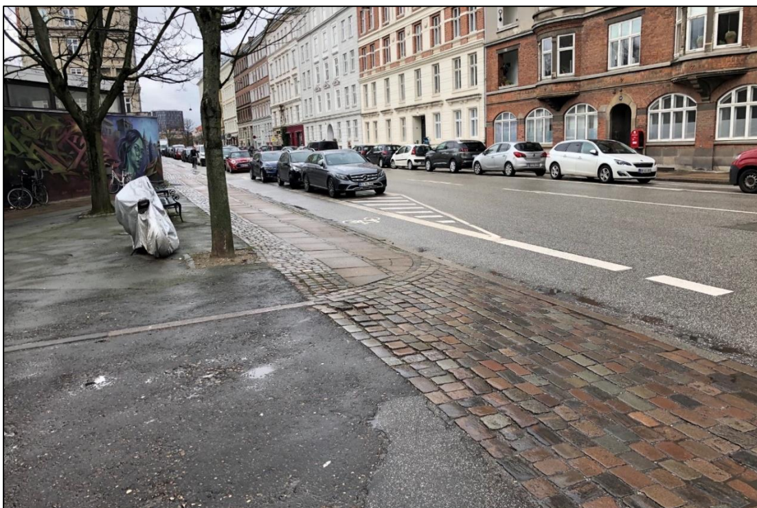
Dette billede viser afmærkning af hjørne med spærreflader. I dette tilfælde for at understrege 10-meter reglen.
