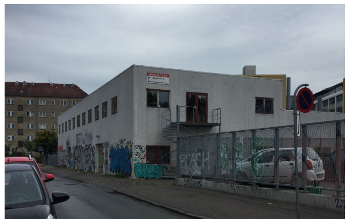
Drejervej 4, set fra Rebslagervej Her opføres nybyggeri.
